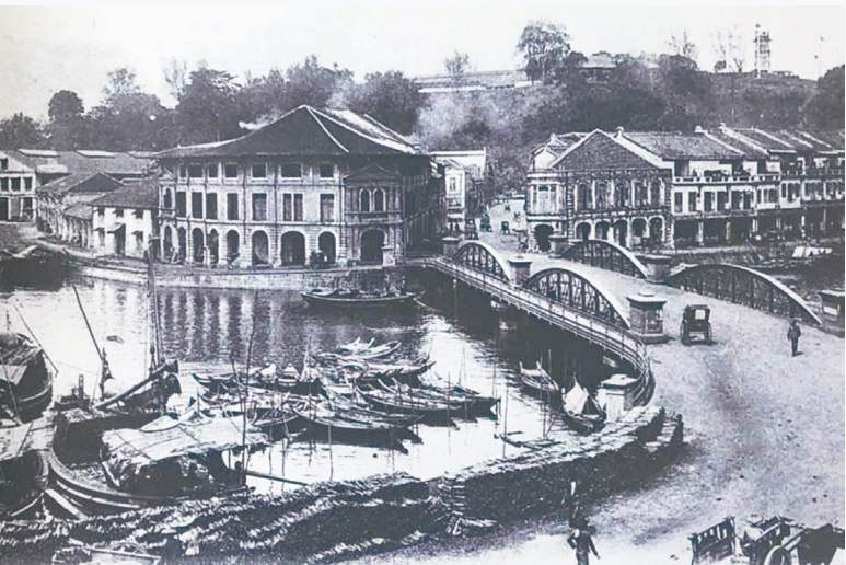
李德桥左边新加坡河畔较矮的第三栋屋子就是端蒙学堂第二期校舍的所在地。（1908 年照片）
